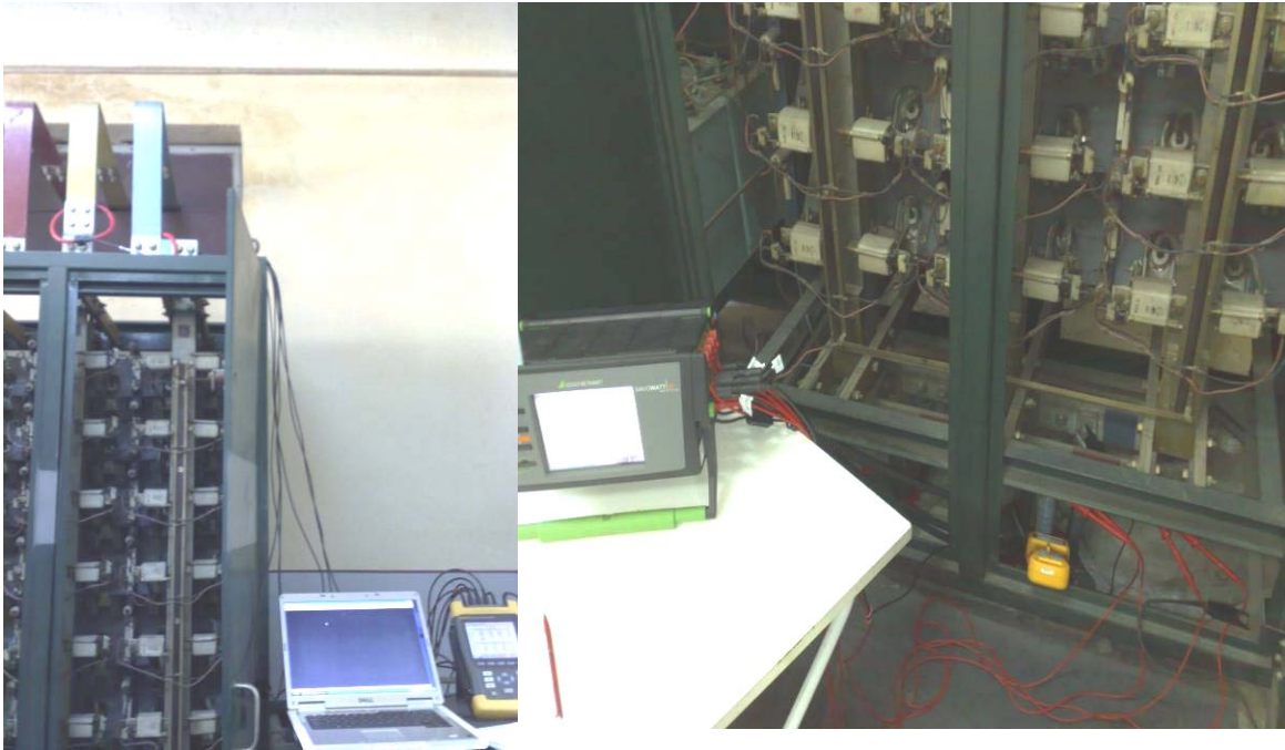
Fig. 4.2. Procedura de conectare a curelelor (senzori curent).(stg.) Conectarea sondelor (clesti crocodil) de tensiune pe bare.(dr.)
